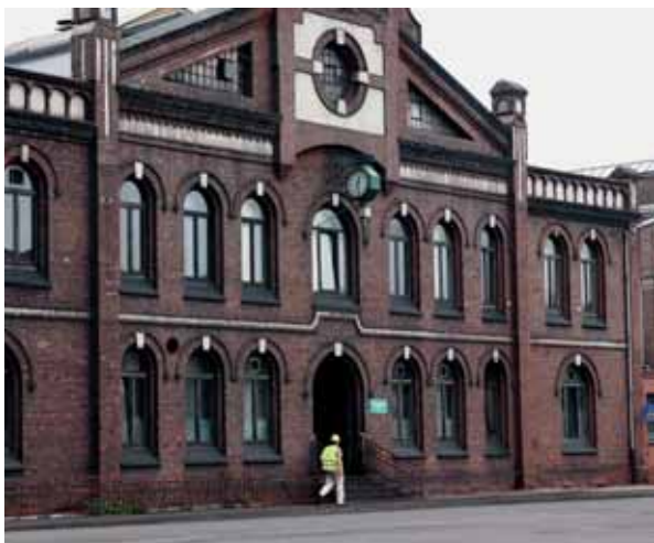
Das Verwaltungsgebäude Bergwerk Ost.
