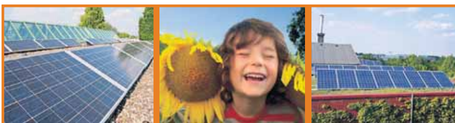
Auf das TechnologieZentrumDortmund installierte asol solar eine 5,78 kWp-Solarstromanlage.
