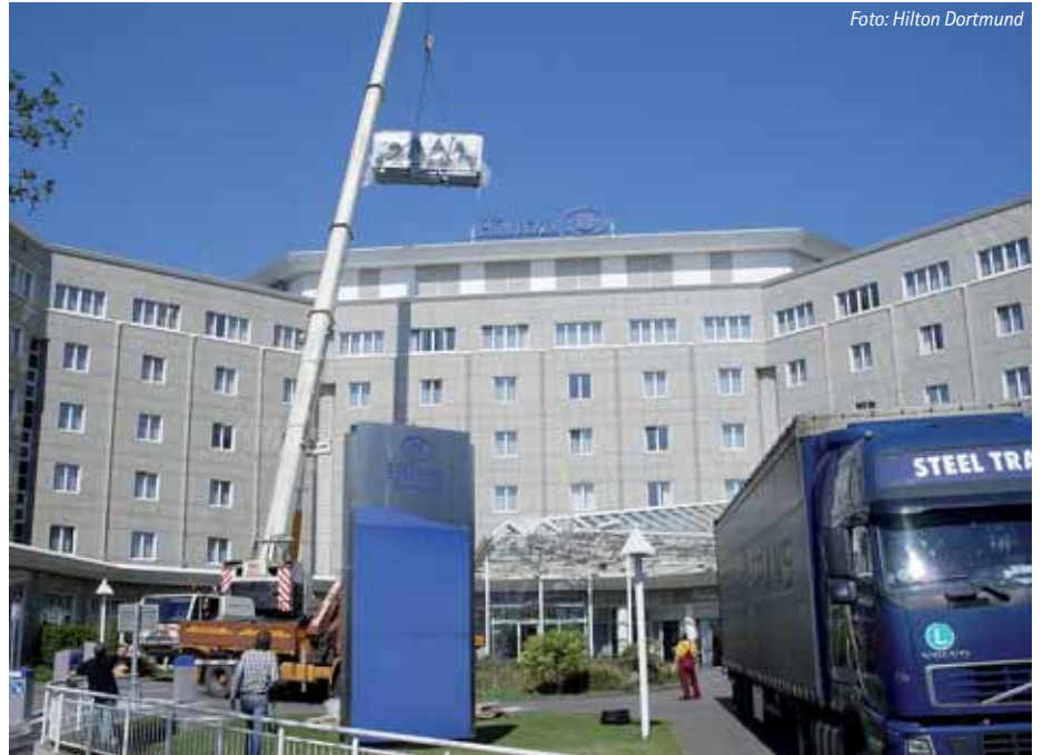
Sechs Tonnen schwer schwebt die Kältemaschine per Kran auf das Dach des Hilton Hotels.
